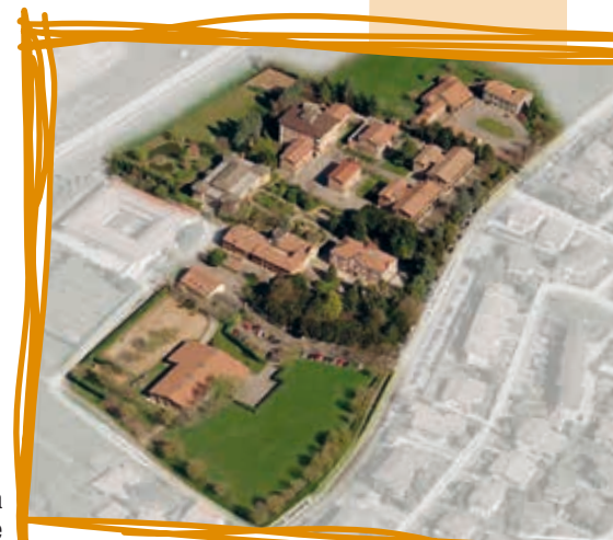
Vista aerea della Casa del Sole
